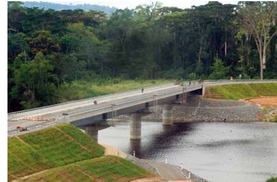
Les ouvrages en dur viendront progressivement se substituer aux vieux ponts en bois, usés par la circulation automobile.
