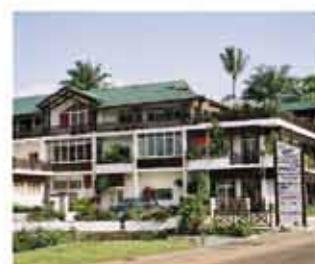
IMMEUBLE BICP - BORD DE MER
