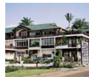
IMMEUBLE BICP - BORD DE MER
